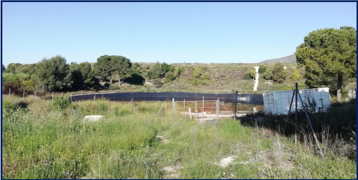
Imagen 13: Vista hacia la zona de actuación desde la entrada al recinto del vertedero (Fotografía 3) las instalaciones no son visibles debido a la altura de la zona de actuación
