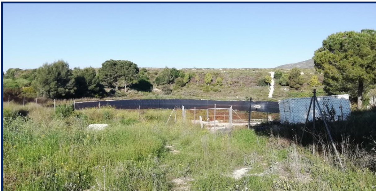
Ilustración 4 detalle de vista desde la entrada al recinto del vertedero a la zona de actuación (balsa de lixiviados)
